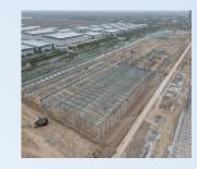
该项目位于陕西省西安市高陵区, 总建筑面积80667.34m²,厂房建筑层 数为一层,屋面高度高跨22m,底跨高 度15m。厂房结构形式为门式钢架,用 钢量2598.53吨。构件类型包括箱型钢 柱、H型钢柱、H型钢梁、角钢柱间支 撑、角钢水平支撑、圆钢水平支撑、圆 管系杆、H型辅梁等。
