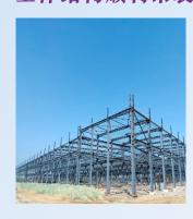
该项目为单层门式刚架结构, 主体 结构由一区、二区、三区、四区呈回字 型布局,其中一区、二区、四区为螺栓 基础, 三区为杯口基础, 建筑面积 45890 m², 用钢量3800吨。钢构件类型 包括H型钢、梁、H型吊车梁、圆管支 撑,C型槽钢组成的桁架制动系统。该 项目功能涉及新能源, 高速机车、无人 机齿轮传动等领域,重点开发、制造各 种类型的减速机及配套产品。
