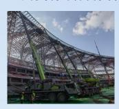
该项目由下部看台劲性钢骨柱和顶 部罩棚钢结构组成,总用钢量约1.8万 吨,杆件总数约3.1万件,建成后能容 纳6万人。体育场钢结构由40榀空间交 叉落地管桁架和20榀出屋面桁架组成, 形成玫瑰花花瓣造型。该项目罩棚钢结 构于2020年6月25日首吊,同年11月 28日顺利合龙。
