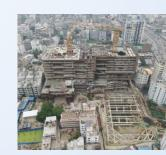
孟加拉BARC大学城项目安装主要分 为A、B、C三个区依次施工, 现已完成 11121吨安装工作,占比65.8%。目 前,现场施工作业主要集中在B区。B区 已施工至5层,将在5月中旬安装至9 层,之后将安装A区的屋面结构。C区目 前正在进行基坑内支撑施工, 在土建基 础筏板施工完成后将开始安装钢结构。
