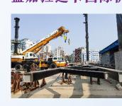
目前,该项目主体结构施工到地面 一层, 现场已将大面积放置地下室, 登 机桥, 电梯, 楼梯埋件, 屋面钢结构预 计今年9月份开始施工。孟加拉达卡国 际机场VMU部分,已完成钢柱安装和焊 接, 主体桁架拼装完成, 近期将进行屋 面桁架吊装,预计5月底完成施工。
