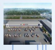
该项目位于北京市顺义区,包含有 主次钢结构、屋面围护体系、墙面 1.2米砖墙以上围护体系、雨蓬、天 沟、落水管、辅房、屋面排烟天窗等, 为常规门式刚架结构,屋面为轻钢屋 面, 总建筑面积25989.48m², 单脊双 坡,单坡长度36m,跨度24m,檐口高度 10.2m,屋脊高度12m。
